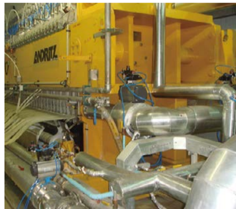
中粮东海粮油（张家港）车间工艺（1）
