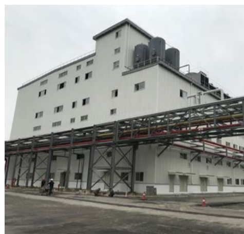
中粮东莞产业园 1000T 精炼车间
